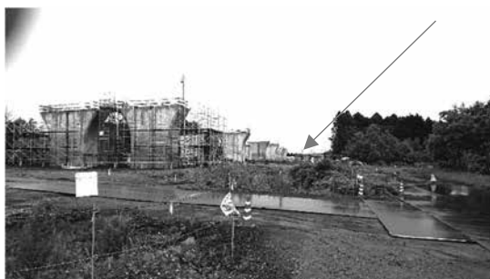
図 1 新東名高速道路の工事現場
