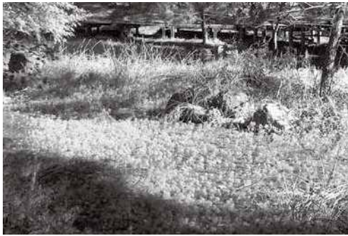
図9 作業前の様子
