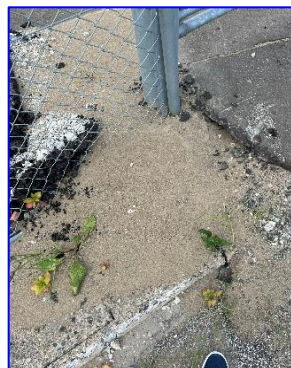
写真3 某工場前歩道
