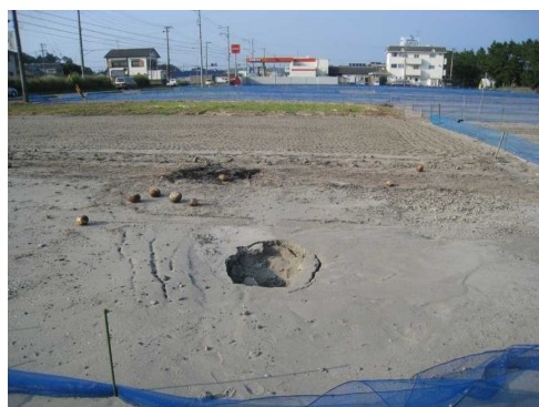
図6 地割れを伴う噴砂No3(スケールは1m)
