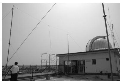
図4-1 アンテナ(本校屋上)
