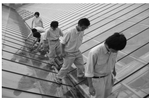
第 22 図:花鳥園大型ガラス温室の屋根・散水確認
