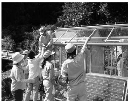
第3図: 温度計設置中の光触媒ガラス温室
