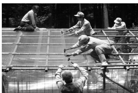
第 19 図: 温室屋根の張替え
