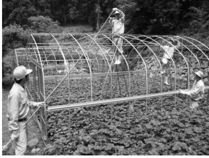
第9図:普及型光触媒温室の組立
