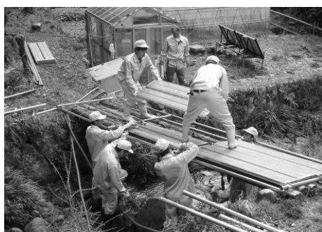
第 21 図:橋の架け替え作業
