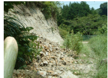
図1 土方泥層外観
