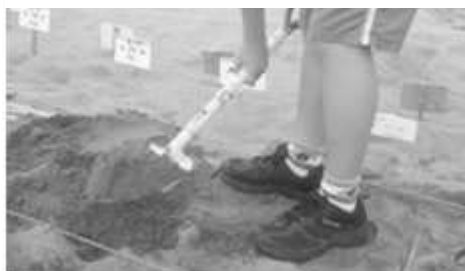
砂を入れて穴を埋める
