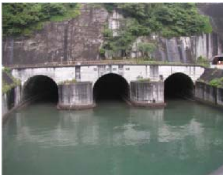
狩野川放水路（写）
