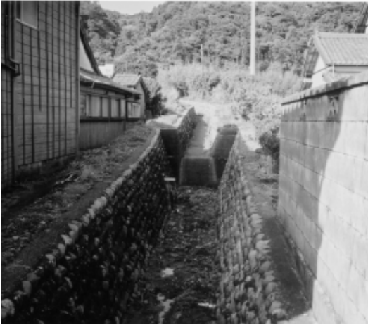
資料7 穴川の改修工事の様子
