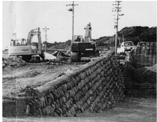
資料10 堀切川の改修工事の様子
